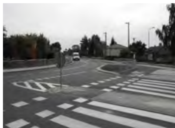
Inwestycja przed i po przebudowie. Fot. ze zbiorów Starostwa Powiatowego we Włodawie
